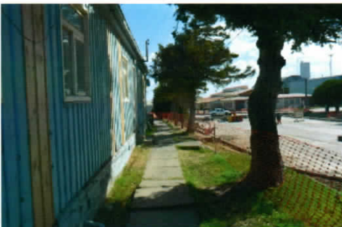
Fotografía N° 4: Pavimentos de hormigón (aceras) no demolidos, sector talud poniente.
