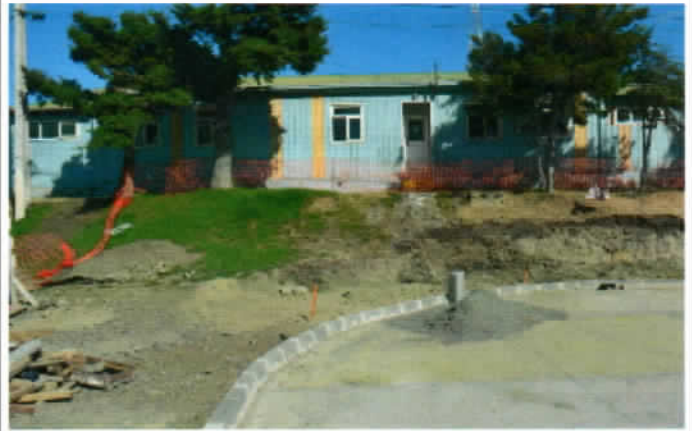
Fotografía N° 8: Pavimento Aceras HCV liso normal, sin ejecutar.
