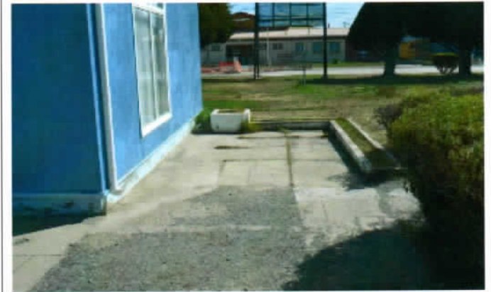
Fotografía N° 12: Pavimento Aceras HCV liso normal, sin ejecutar.
