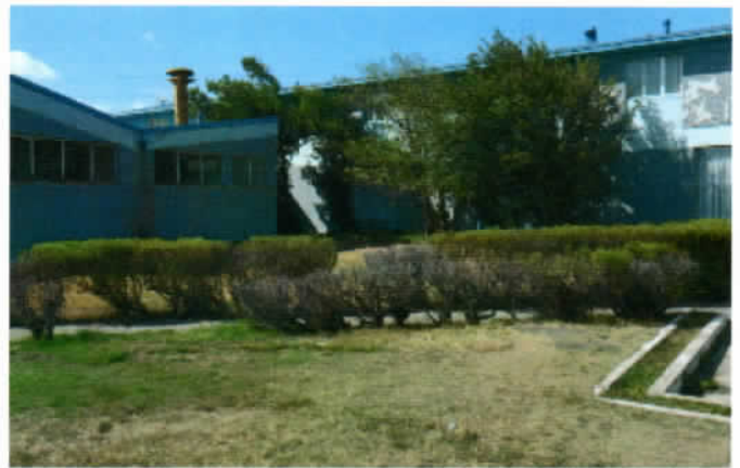
Fotografía N° 14: Pavimento Aceras HCV liso normal, sin ejecutar.
