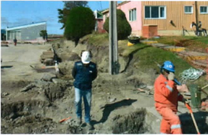
Fotografía N° 7: Pavimento Aceras HCV liso normal, sin ejecutar.
